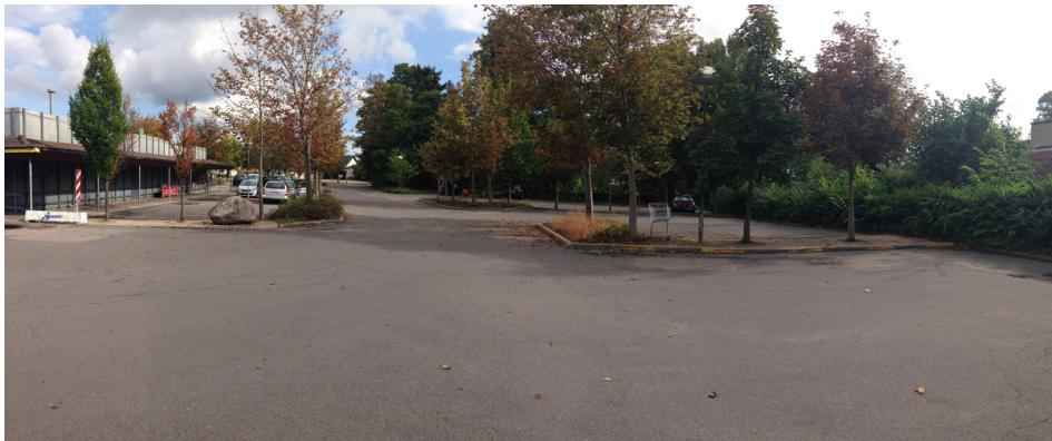
Parkeringspladsen med asfalt og kantsten.
