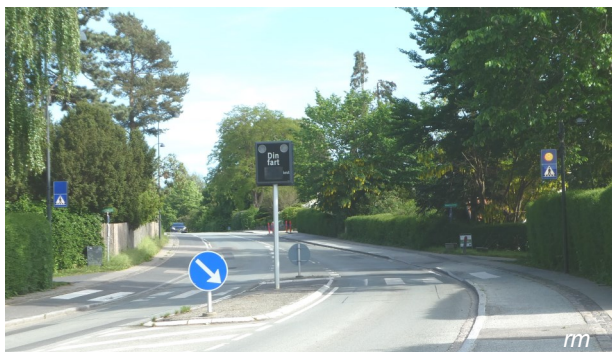
Lys og skilte ved fodgængerovergang på Rundforbivej nær Bakkevej/Kratmosevej er blevet moderniseret.
