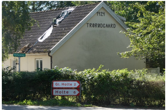
Trørødgaard set fra Torvet. Ombygningen er nu i fuld gang, alt indvendigt er revet ud.
