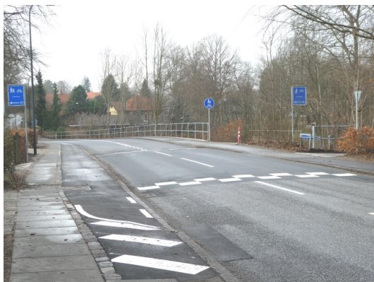
Cykelstien fortsætter ikke, men svinger brat ud på kørebanen. Må ændres når resten af Frydenlundsvej bliver en "2 - i - 1" vej.
